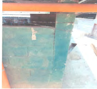
Foto 2: Mejoramiento modulo de corredor.
