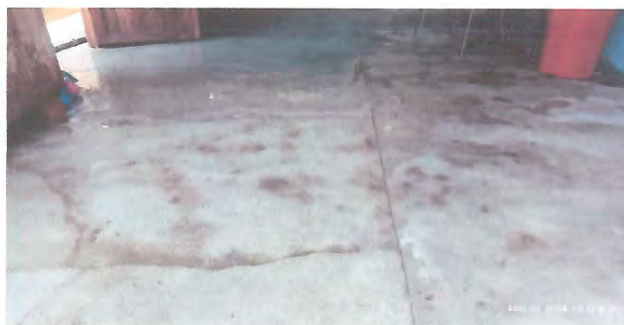
Foto 2: Mejoramiento de piso (Cerámico de alto impacto)
