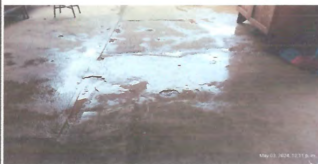
Foto 4: Mejoramiento de piso (Cerámico de alto impacto)
