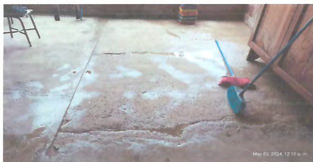
Foto 3: Mejoramiento de piso (Cerámico de alto impacto)
