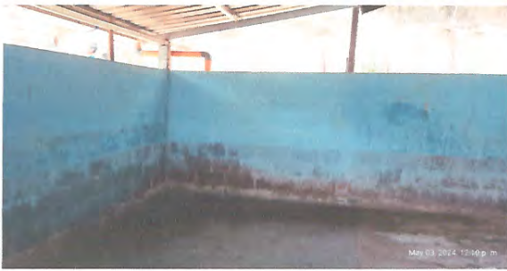
Foto 1: Mejoramiento modulo de corredor.
