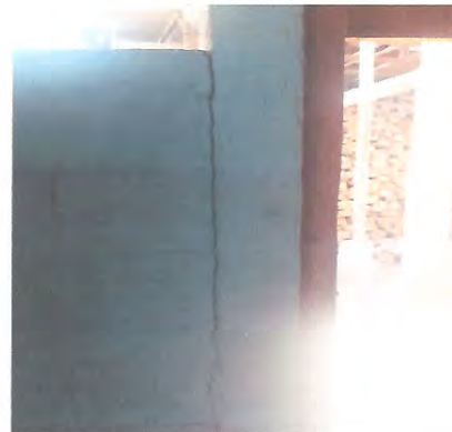
Foto 4: Mejoramiento modulo de corredor.
