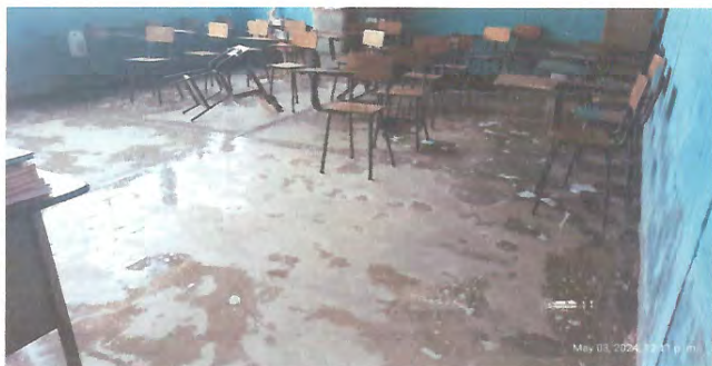
Foto 1: Mejoramiento de piso (Cerámico de alto impacto)
