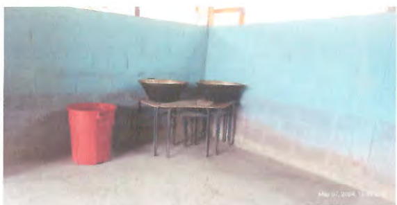
Foto 3: Mejoramiento modulo de cocina.
