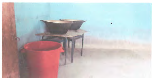
Foto 1: Mejoramiento modulo de cocina.
