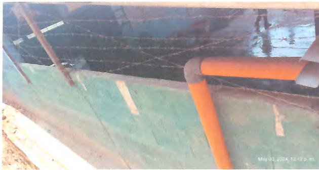
Foto 3: Mejoramiento modulo de corredor.
